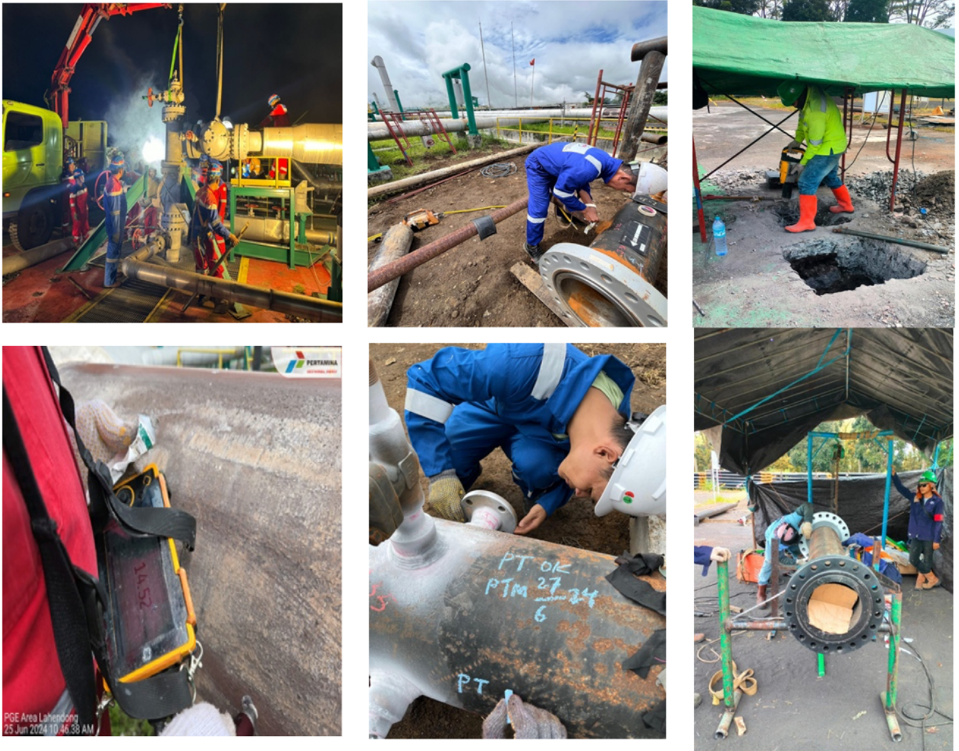
Gambar 6. Dokumentasi proses eksekusi jalur pipa baru sumur LHD -X
