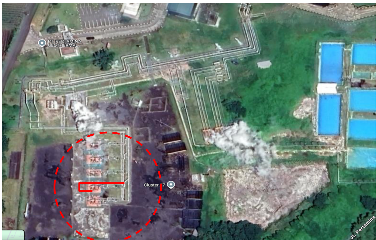
Gambar 2. Jaringan Pipa Fluida Panas Bumi PLTP Lahendong Unit 5 & 6 (Cluster 27)
